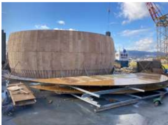
7階プラネタ工事進捗の様子
